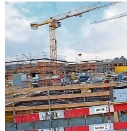
Die Bauarbeiten sind in vollem Gange.
